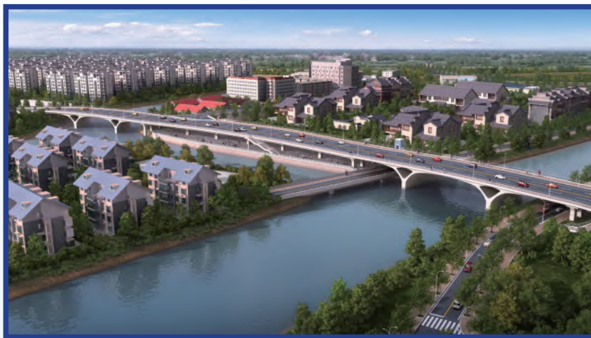
公司首个 EPC（设计施工）市政项目——嘉兴市三元路（建国北路—东方路）建设工程 EPC 项目
