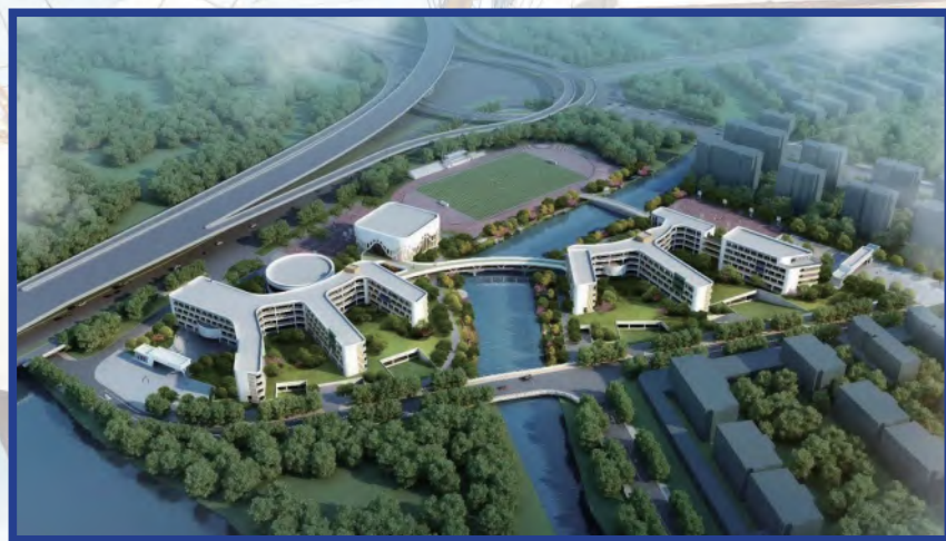
公司在建 EPC 项目——省身学校项目
